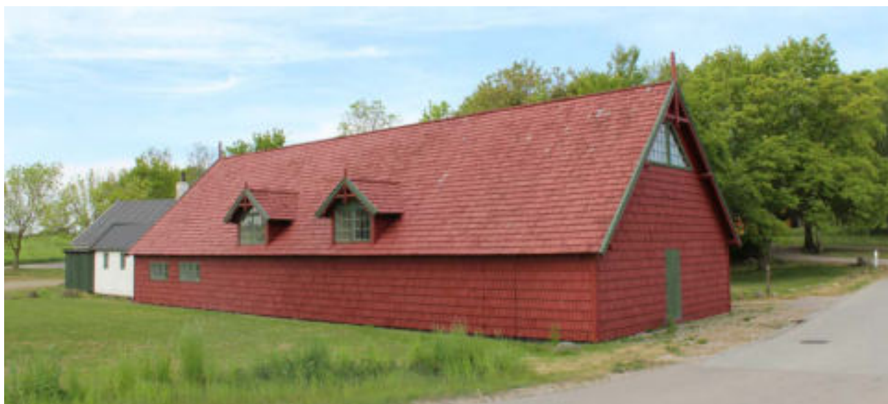
Øvelses- og forsamlingshus fra 1880 i Stenstrup, opført i nationalromantisk stil og beklædt med træspån, tegnet af Andreas Bentsen
