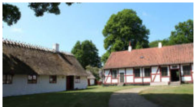
Præstegård i Egebjerg fra 1776. "Ods" bindingsværk til venstre, vestsjællandsk bindingsværk til højre
