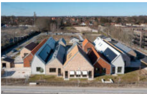
En cirkulær bygning, bygget med materialer fra en nedrivning på samme sted. Bygherre Gladsaxe Kommune
