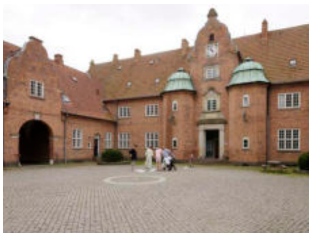
Hovedbygning i Annebergpraken, tegnet af Kristoffer Varming er fredet
