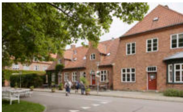
Annebergpark kulturmiljø, i bedre byggeskik stil. Bygninger indenfor området er bevaringsværdigt eller fredet
