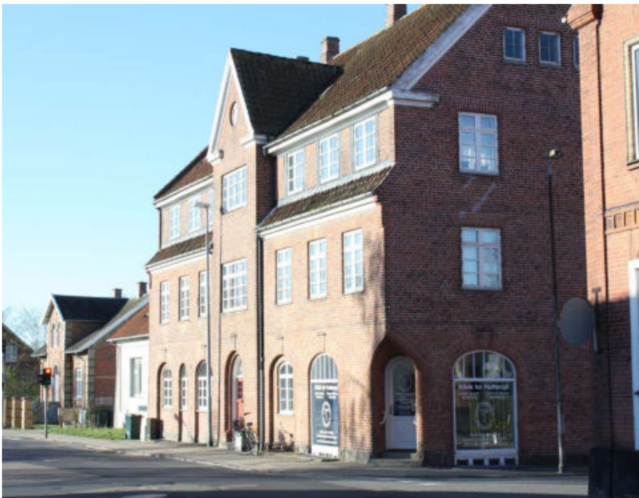
3,5 etagers byvilla tæt på stationen i Nykøbing, tegnet i 1916 af Einar Andersen. Husene ved siden af nedrivet for at gøre plads til parkeringspladser og et supermarked i et plan
