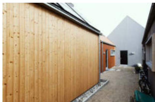
Andelssamfundet Hjortshøj i Aarhus med både ejer-leje- og andelsboliger. Den første boliggruppe blev bygget i 1992. Der bor nu 300 mennesker i 8 forskellige bogrupper
