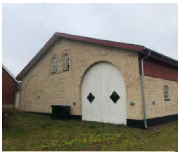
På Stålhøjvej i Asnæs har bygherren besluttet at beholde den gamle gård fra 1900-1923 og lave det om til 17 moderne lejligheder. Det betyder, at vi både sparer på jordens ressourcer, men også at områdets kulturhistorie bliver bevaret
