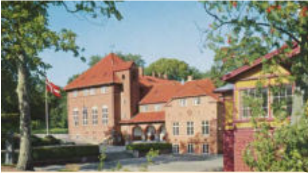
Vallekilde Højskoles bygningskompleks fra 1907, tegnet af Martin Nyrop. Til højre det nationalromantiske gymnastikhus, som han opførte med Andreas Bentsen i 1884
